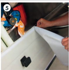
5 Zugeschnittene Planen an Sektionaltor befestigen
