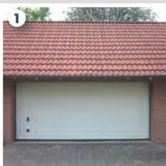
1 Ränder des Tores reinigen und Sektionen ausmessen
